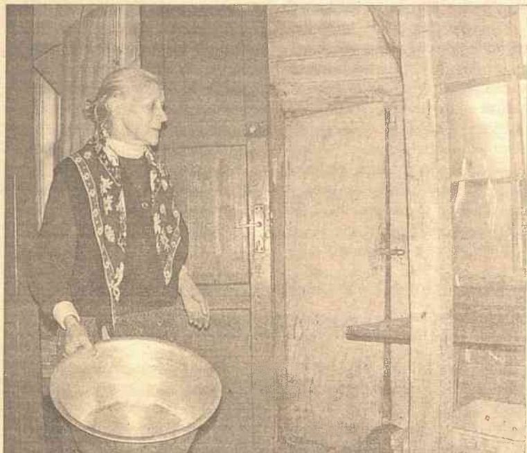
W nieremontowanej części chwieje się nie tylko podłoga, ale też ściany, a kiedy pada deszcz, bez miednicy się nie obejdziesz
