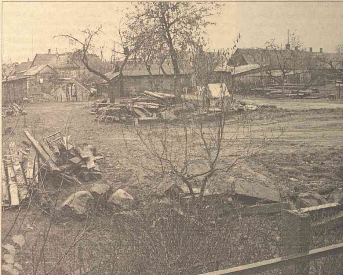
Na miejscu ładnego, odremontowanego domu zostało pogorzeliisko
