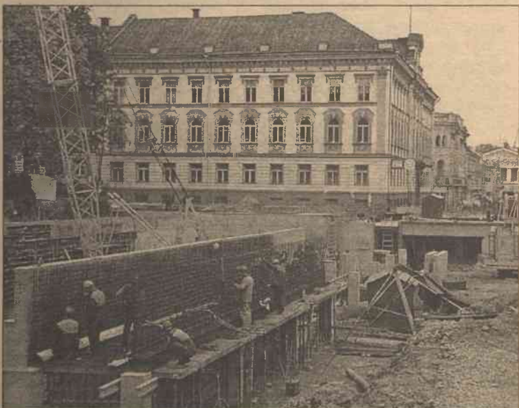
Prace na alei Giedymina prowadzone są z dwóch stron – od Katedry i obok Placu Samorządowego
