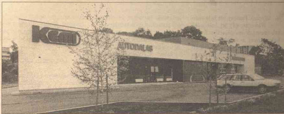
Nowo zbudowany, niebiesko-biały, gmach serwisu Kemi jest przykładem nowoczesnej architektury przemysłowej
