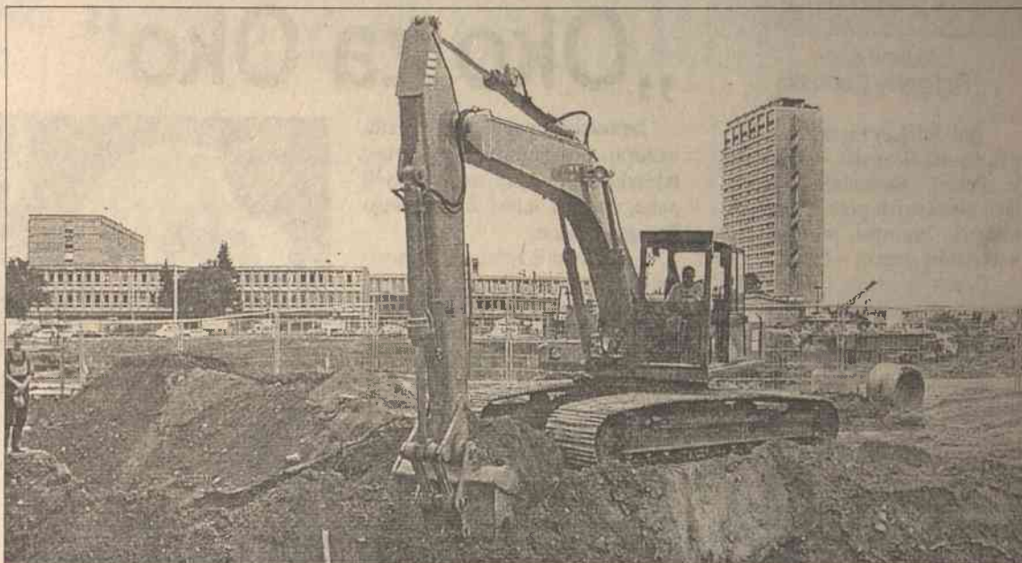
Koparka – „pionier” każdej budowy
