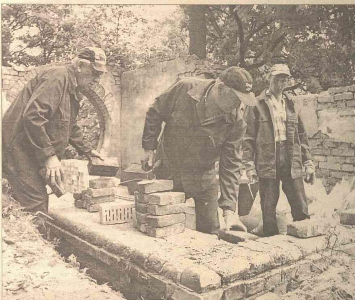
Trójka budowlanych z „Alrasty” zaczyna od fundamentu
