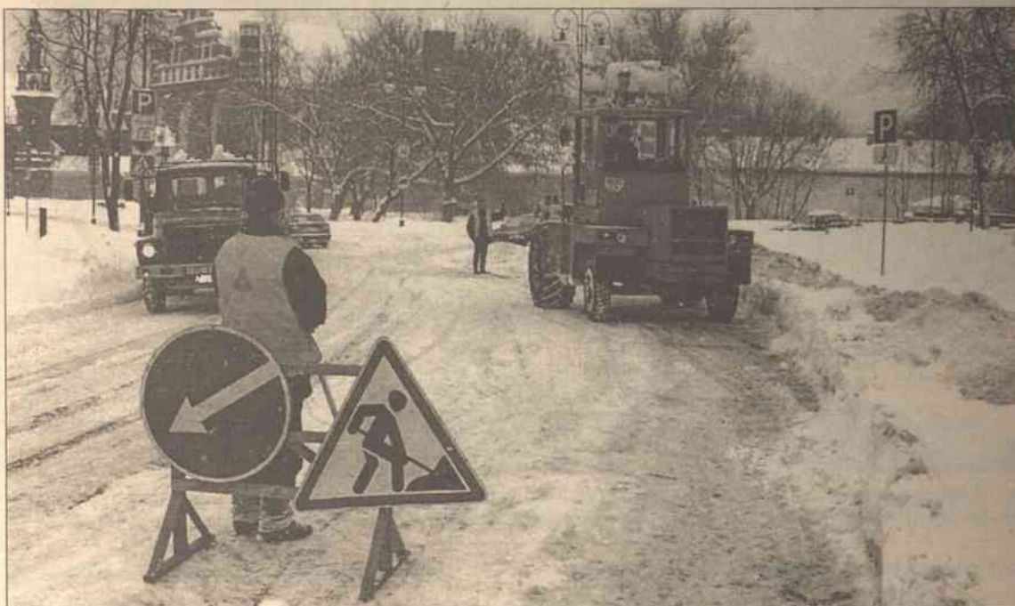
W walce ze śniegiem dobre jest wszystko: spycharki, ładowarki, wywrotki, no i, oczywiście, od wieków wypróbowana łopata
