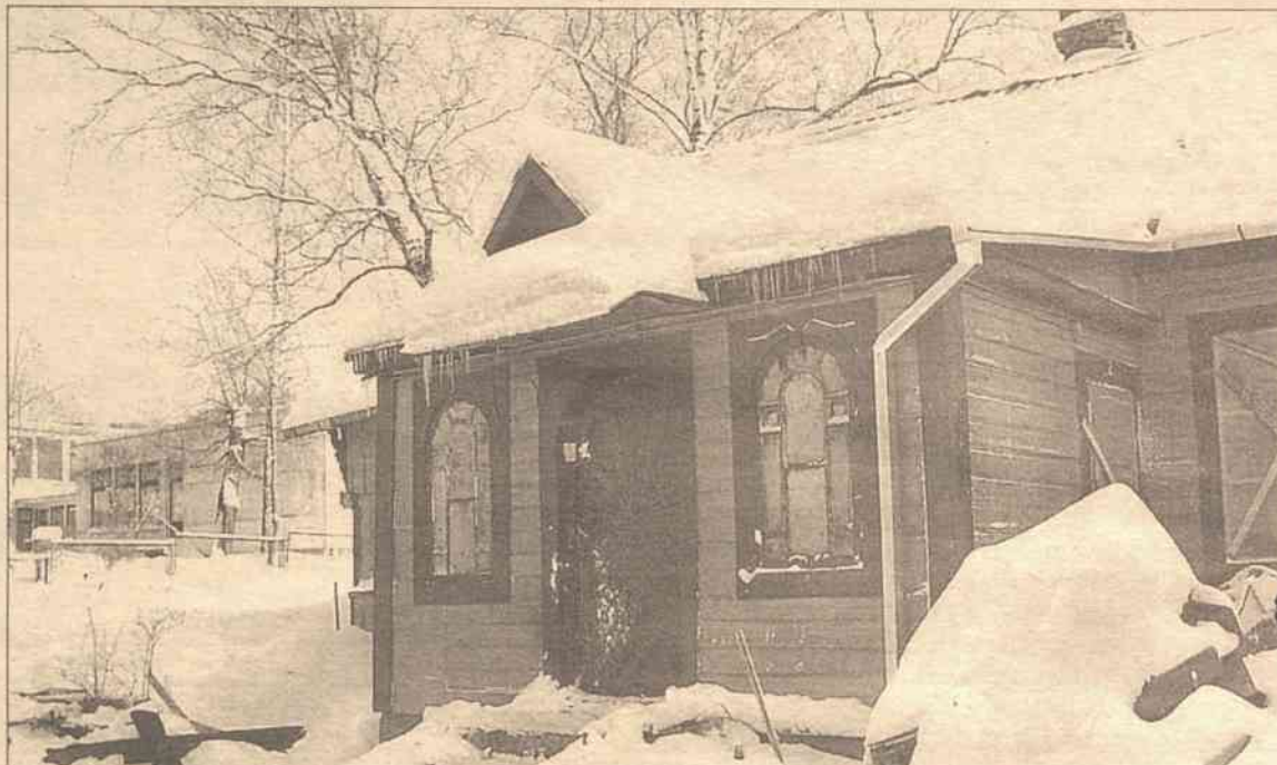
W tym skrzydle rozpoczął się pożar
