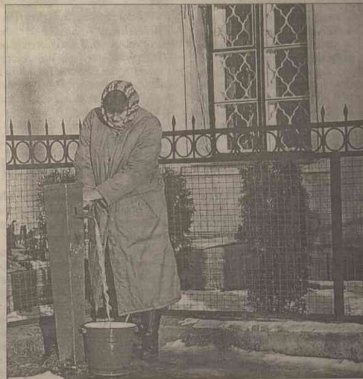
Studzienka nie ma ścieku, więc woda płynie na ulicę
