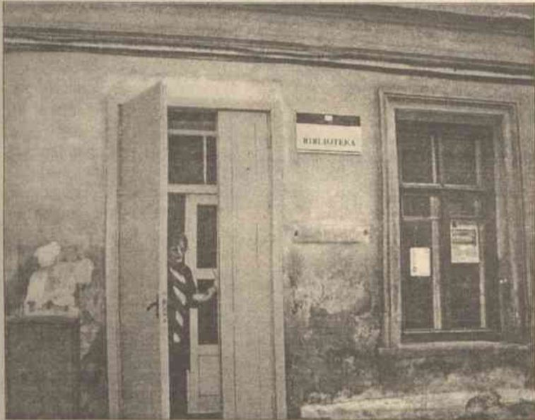
Wejście do Biblioteki im. Tomasza Zana
