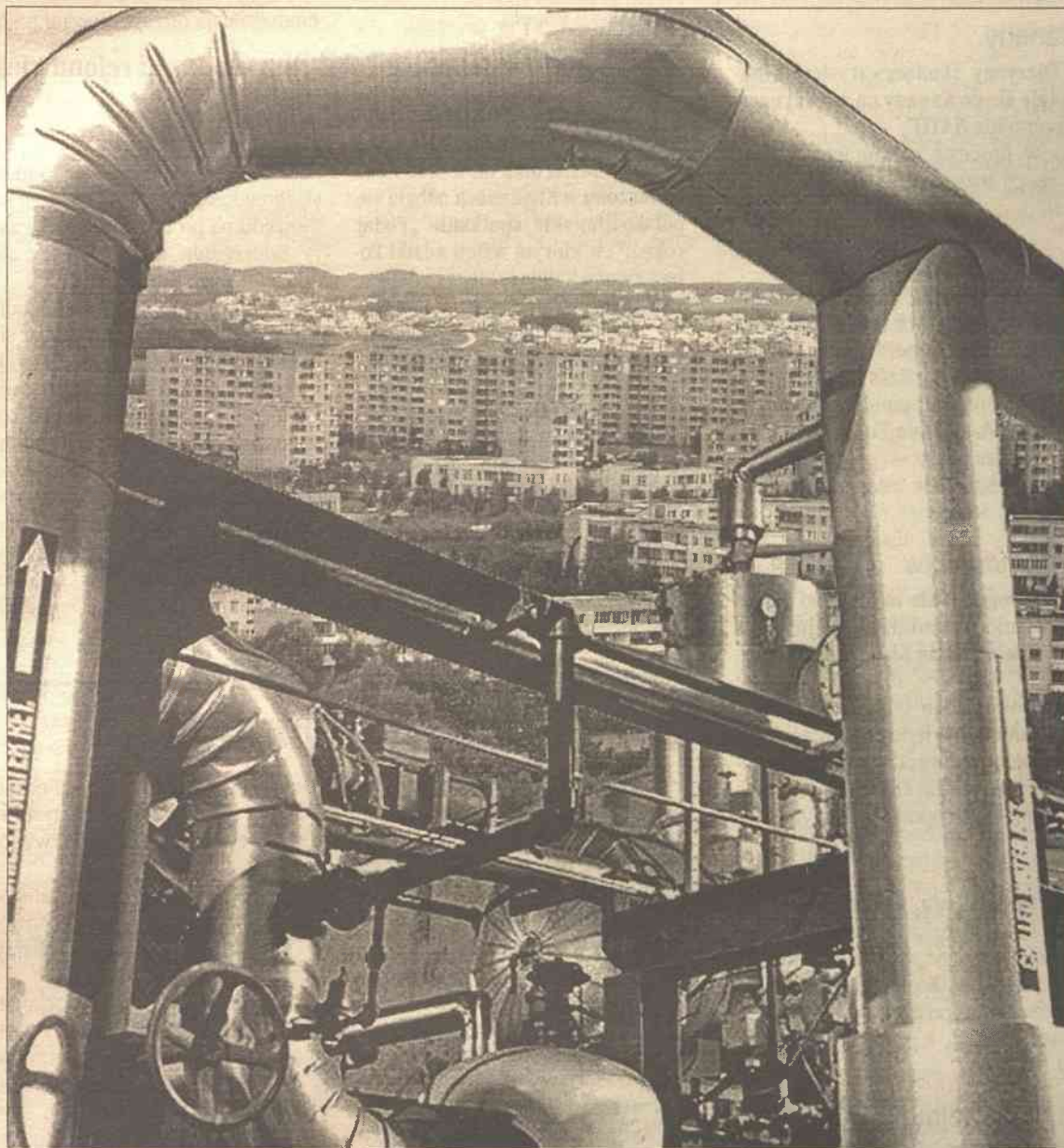
Czy wydzierżawiając na 15 lat swoje sieci ciepłe, samorząd nie wpadnie w inne sieci
