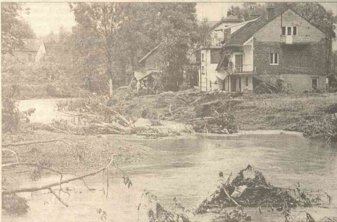
Woda nieubłaganie niszczyła wszystko podrodze
