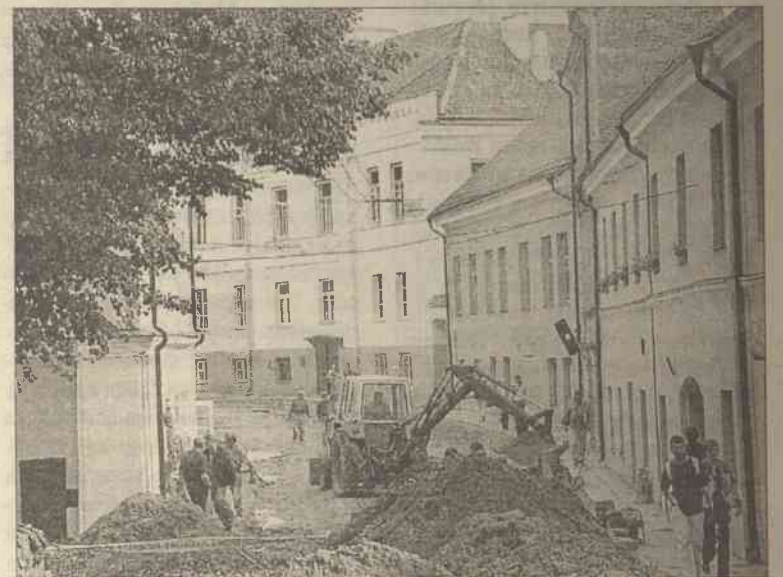
W szybkim tempie prowadzone są prace remontowe przy odnowie ulicy Užupio, która otrzyma nową nawierzchnię
