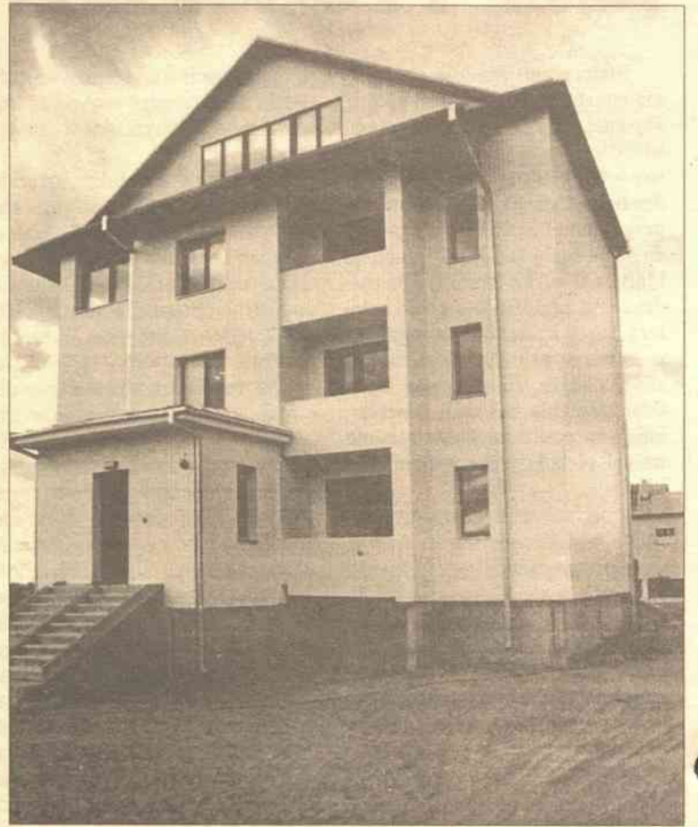
Stal, beton ... i PCV dla estetyki i zachowania ciepła
