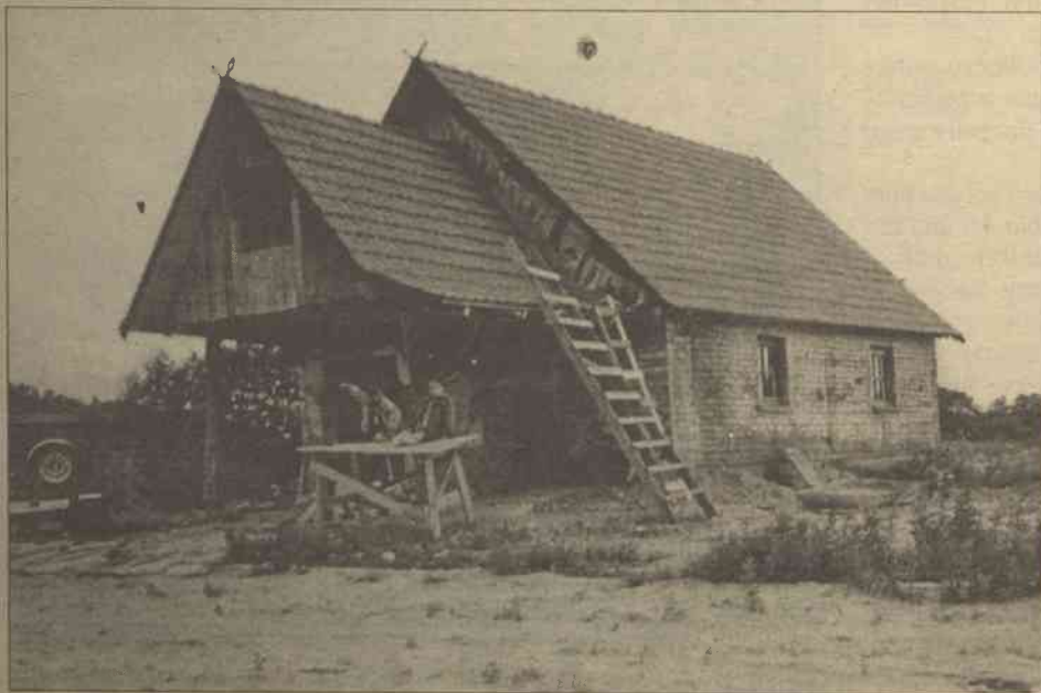
Tak wyglądał dom przed rekonstrukcją...
