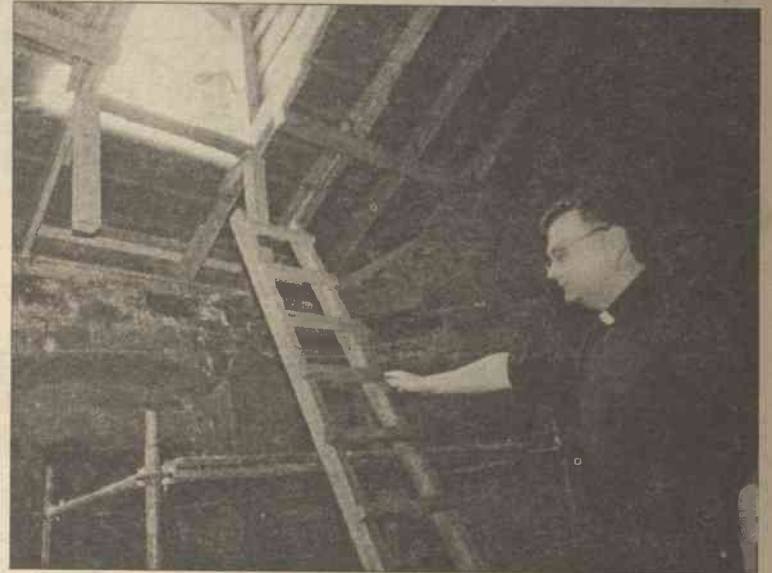
Dach „ruszył” — cieszy się proboszcz Mirosław Grabowski
