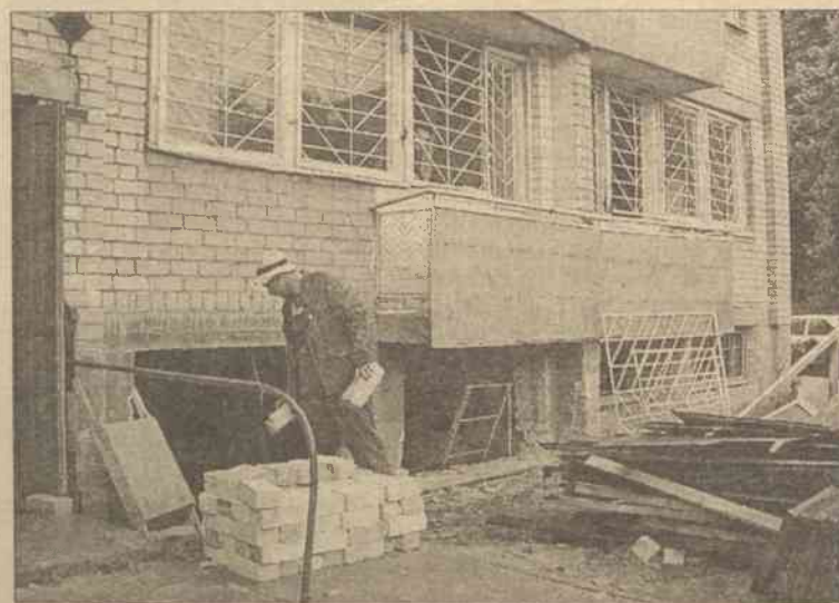
W tej opuszczonej półpiwnicy będzie czysto i jasno
