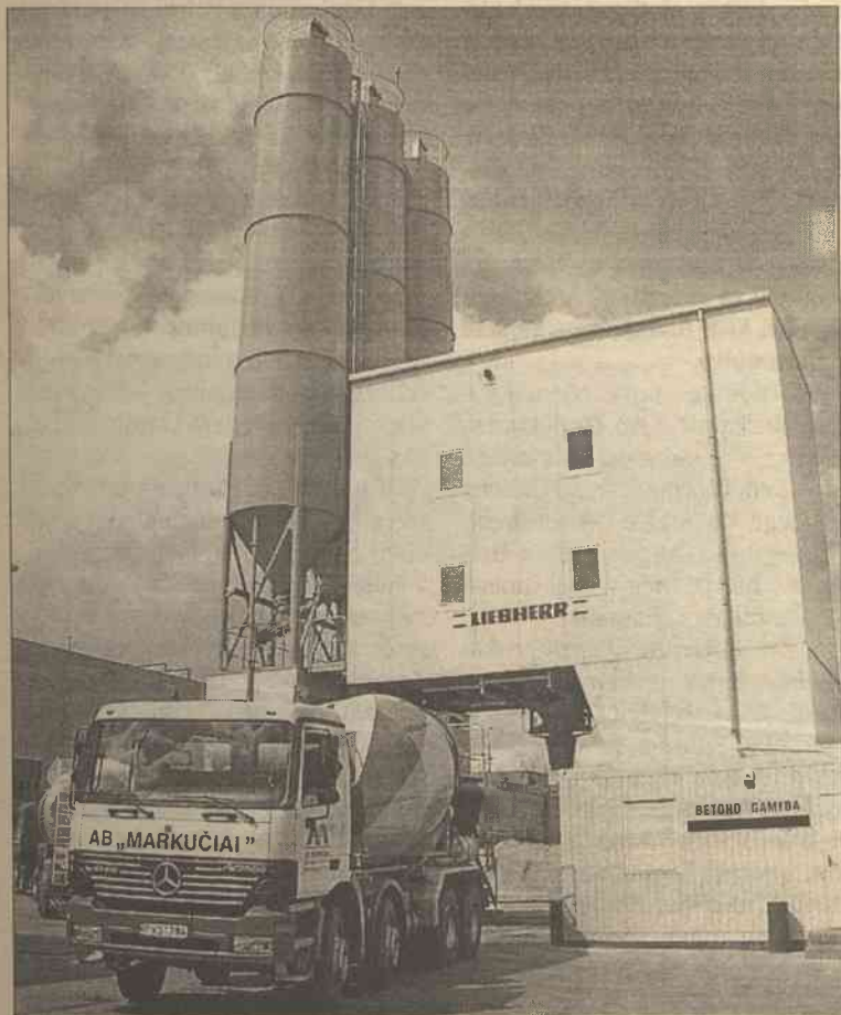
Wszystkie urządzenia są zagraniczne, a pojemność nowego miksera wynosi aż 9 metrów sześciennych
