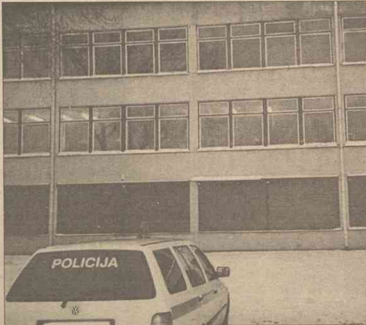
Opłaty za pomieszczenie na trzecim piętrze w Skojdziszkach wynosiły ponad 4.000 litów Fot. autorka
