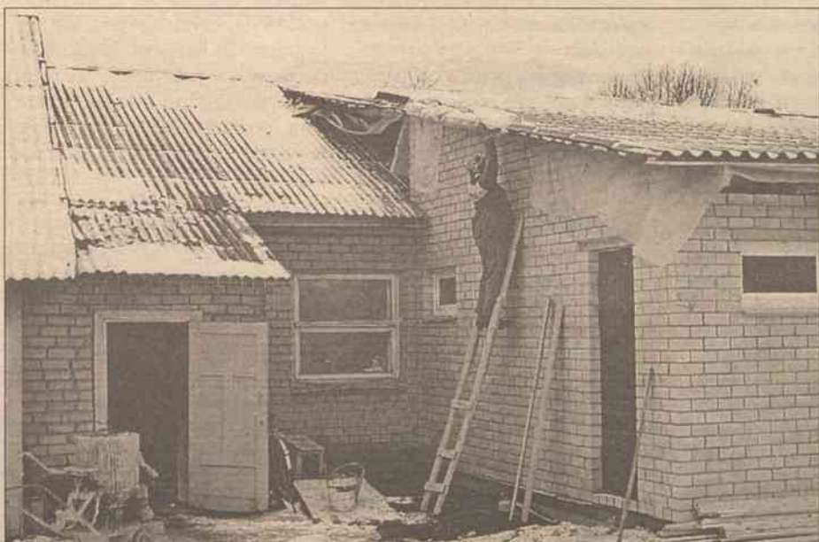
Budowa niezbędnych obiektów dobiega końca
