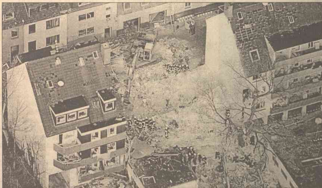
Po eksplozji czteropiętrowy budynek został całkowicie zniszczony
