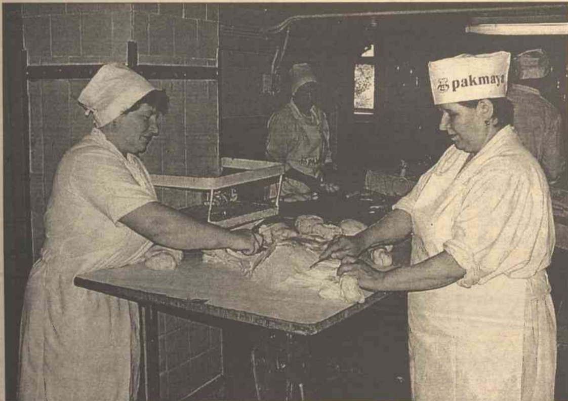
Solecznicka piekarnia potrzebuje rekonstrukcji, co widać nawet nieuzbrojonym okiem
