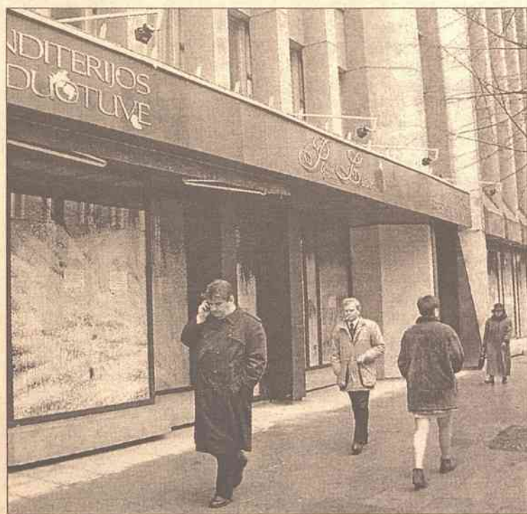
W "Ponių laimė" już od trzech miesięcy trwa remont
