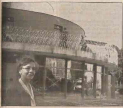
▲ Na zdjęciu: Jarmila Hájková na ile przyszłej siedziby Teatru Lalek w Ostrawie budowanej według projektu inż. arch. Petra Hájka z Pragi. Fot. M. RADŁOWSKA-OBRSNİK
