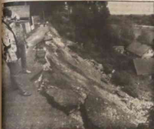
W blasku domkom rodzinnym w swego podwórka oraz domostwu pana Josefa Kována wzniesie zagroza obsuwajace się po niedawnej fali deszczów zbocze dawnoznany łopca zwanego Ujala. Sytuację spowodował praski właściciel 70 arów lasu, który dla przed niedawem wykarcał 30 arów drzew. Na szerokości starocina gminy, Květlina (na zdjęciu w towarzyszywie J. Kována) kłosa na zboczu, które zaczęło się ruszać już w okresie powodzi przed dwoma laty, w związku z czym specjaliści zalecili nie ruszać porastającej go wegetacji, ponieważ tak szybko, że gmina nie miała szans jej powstrzymać. „Reszty lasu nie udało się upilnować” - podkreśla starocina. (zm) Fot. JERZY KUBIENKA
