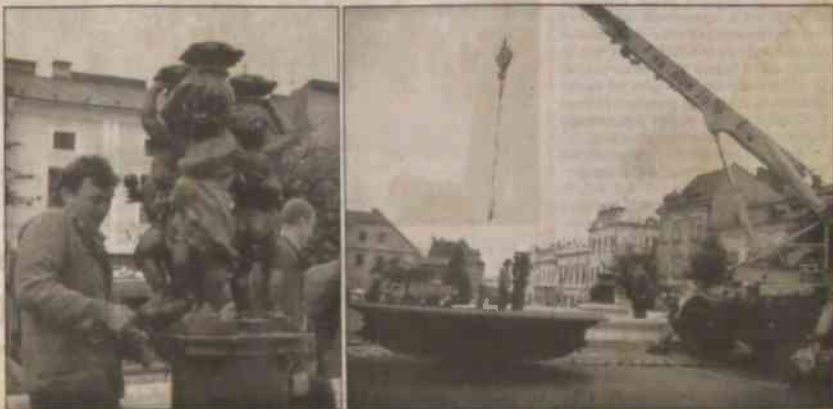
▲ Zaledwie para rekonstrukcji wymagała dotycząca fontanna miejska w Karwinie-Fryszcie. Wybudowała ją w 1900 roku wiedeńska firma Georg Wirth. Ostatnia naprawa tej dominanta fryszackiego rynku zakończyła się w ubiegłym wtorek. Jak powiedział „GL” Zbigniew Gajda, kierownik wydziału przedsiębiorczości, usług i transportu Urzędu Miejskiego w Karwinie, prace restauratorskie prowadziło Muzeum Techniczne z Brna. Koszt naprawy fontanny zamyka się kwotą 565 tys. koron. Fot. M. RADŁOWSKA-OBRSUNIK
