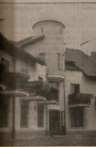
▲ Fragment rozległego kompleksu efektywnych budynków składających się na Dom Pomocy Społecznej w Gorzycach. Fotografia jest przy trasie Chalupki - Włodzisław Śląski. Architektura domu wpisana jest w piękny krajobrazowy park o powierzchni 100 ha. ● Pensjonariusze DPS w Gorzycach w sali ergoterapii - czyli terapii zajęciowej. Fot. archiwum DPS
