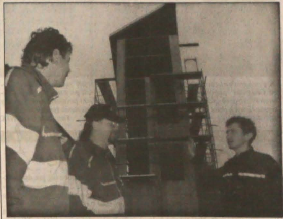
▲ Budowę specjalnego poligonu do ćwiczeń strażaków kończy karwińska profesjonalna jednostka Straży Pożarnej. Czteropiętrowy obiekt treningowy będzie miał m.in. uszczelnione okna, co pozwoli prowadzić ćwiczenia z aparatami tlenowymi w zadymionych pomieszczeniach. Fot. JAN OLEJNIK
