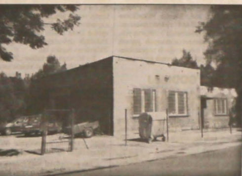
▲ Niedaleko skrzyżowania pod kościołem katolickim w Trzynie (w kierunku Lesznej) stoi budynek byłej wytwórni moszczu. Zlikwidowano ją już przed czasem, a budynek objęła najpierw hurtownia bliżej nieokreślonego towaru, obecnie zaś firma REMER, zajmująca się pomiarami i regulacją systemów grzewczych - gazowych i elektrycznych. Ludzie jednak stale wspominają, jak to kiedyś w okolicy marmolowano się mniej owoców, bo nawet te opadnięte można było przerobić na moszcz lub alkohol. Fot. IRENA STONAWSKA
