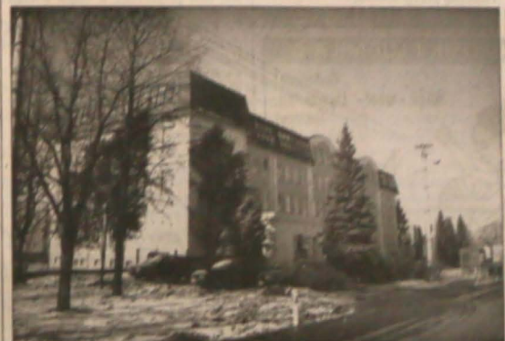
▲ W 1997 roku w Suchej Górnej oddano do użytku nadbudówkę czeskiej szkoły. Wyeliminowano tak konieczność przechodzenia dzieci na zajęcia przez zeszyczaną jezdnię. Koszty budowy - 12,5 mln koron, z czego 3 mln pochodziły z kasy Kopalni Ostrawsko-Karwińskich. ◆ Pałac Miroslaw König chwalił sobie czystą robotę w gazowej kotłowni polskiej podstawki.
