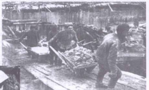
Więźniowie łagrów przy budowie Kanalu Białomorskiego (1932-33), jednej z „wielkich budów socjalizmu”. Budowa tego kanału, łączącego Morze Białe z jeziorem Onega, pochłonęła życie kilkudziesięciu tysięcy osób, głównie chłopów deportowanych w czasie kolektywizacji wsi.
