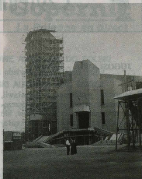
Pabianicki kościół w budowie
