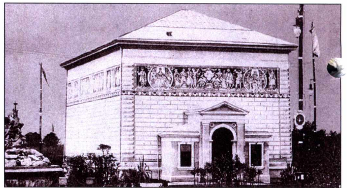
PWK – Pawilon Matejki tzw. Mauzoleum, proj. arch. Fr. Skowron
