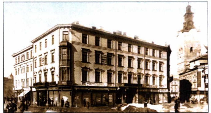
Budynek nr 8 – Dyrekcja Galicyjskiej Kolei i kawiarnia Monopol – wyburzony w 1912 r.
