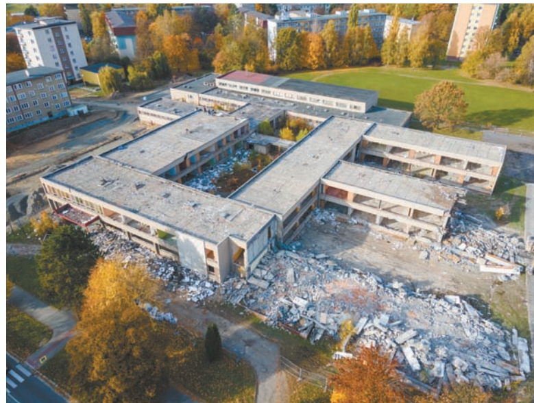
• W tym miejscu ma powstać nowa hala sportowa. Fot. Petr Sznepka/UM w Hawierzowie
