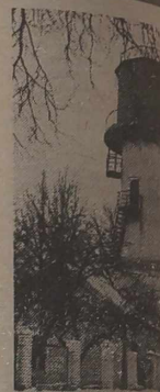
Więć cieniem wodociągu na rogu ul. Wodnej dziś już nie gra swą dawną rolę, po prostu w Górnej Kolonii brakuje wody. Ta wyzsa część miasta, dobudowana w okresie porównywalnym Ognis obok wjeżdżał się mój i straż połama na jąca do dyspozycji cztery weso strażackie.
