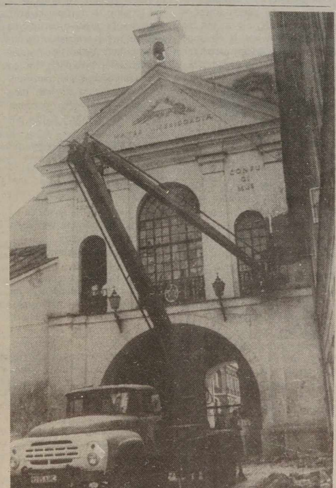
Już zakończono układanie nowej nawierzchni na ulicy Ostrobramskiej. Będzie teraz z szarej kostki bazaltowej. Z kolei budowlani przystąpili do odnawiania elewacji Kaplicy Ostrobramskiej.
