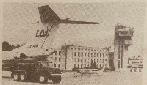
NA ZDJĘCIU: rekonstrukcja gmachu punktu kontrolno-dyspozytorskiego. Fot. W. Čairis
