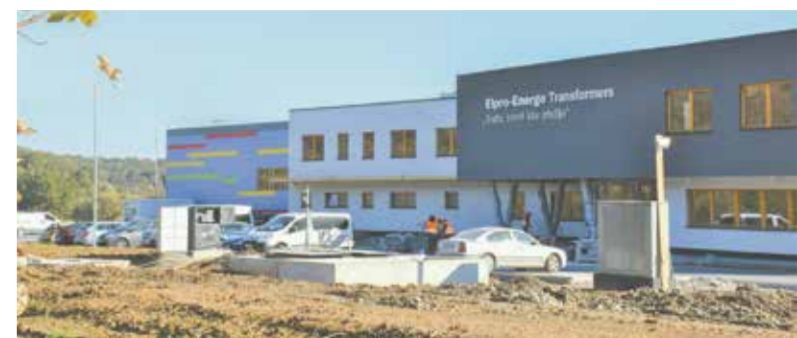
W Gnojniku już stoją nowe obiekty. Fot. DANUTA CHLUP
