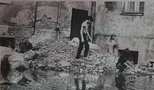
...wysypisko, okupowane przez dzieciarnię jako miejsce zabaw, na podwórzu spryatywanego domu zniknie na zawsze.
