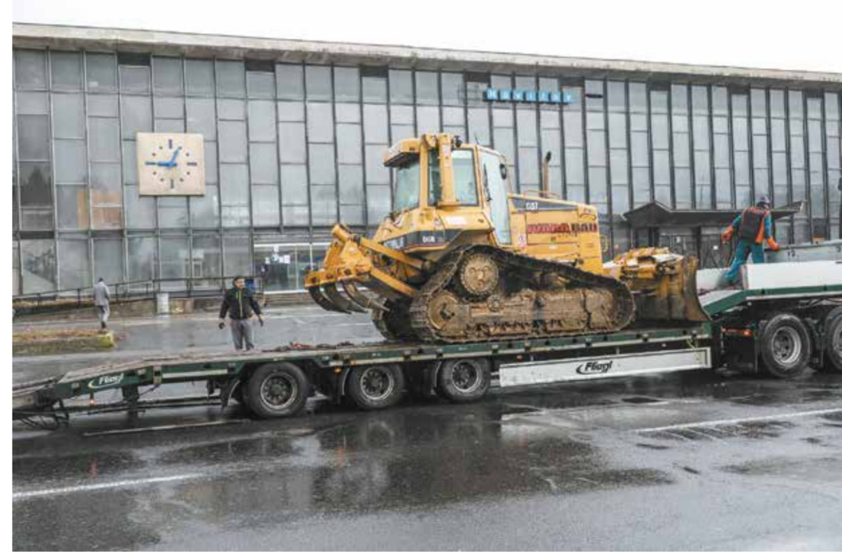
Przestrzeń przed hawierzowskim dworcem zmienia się w plac budowy.
