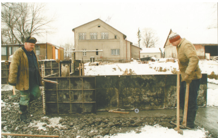
● Ale ten czas leci... W maju minie 20 lat od wykonania tego zdjęcia. Fotoreporter uwiecznił na nim prace przy budowie fundamentów pod nową PSP w Gnojniku. Fot. WIESŁAW PRZECZEK
