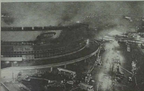
Rano 15 grudnia w centrum Budapesztu, w hali sportowej, zbudowanej przed 20 laty, wybuchł pożar, w którego gaszeniu uczestniczyło wśmiesz wozów strażackich. Informacji o ofiarach nie podaje się, każdego roku w tej hali odbywają się targi bożonarodzeniowe. Fot. EPA - ELTA
