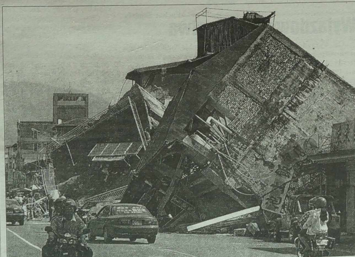
Już 2003 osoby poniosły śmierć w wyniku poniedziałkowego trzęsienia ziemi na Tajwanie - podał wczoraj tajwańskie władze. Rannych jest 4400 osób, a ponad 100 tys. zostało bez dachu nad głową, 2600 osób jest uwiecznionych pod gruzami budynków.
