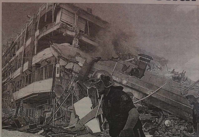
Wskutek trzęsienia ziemi zawałiło się 35 budynków, w tym 22 mieszkalne
