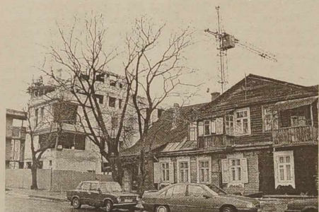
Coraz śmielej między drewniane domki wiskają się żurawie budowlane.
