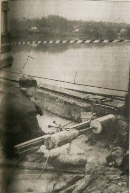
▲ Prace w 42-letniej historii Zapory Żermanickiej. Remont kapitalny i rekonstrukcja tamy trwać będzie do listopada br. Do tego czasu wstrzymano tu ruch kłoboczek. Wody w poważnym stopniu uszkodziły izolację jezdną, co z kolei spowodowało m.in. powazne zacięcia i żelbetowej konstrukcji tamy. Podczas remontu awaryjnego np. ze wierzchnia warstwa bruku i betonu mierzy 16 cm zamiast wymaganych 32 cm. Jak poinformował inż. Pavel Konšela, przedstawiciel inwestora, projekt rekonstrukcji zapory z roku 1997 mocno się już zestarzał - technika od tej pracy odnotowała ogromne postępy. Na zdjęciu: prace na koronie tamy Zapory Żermanickiej. Fot. JERZY KUBIENKA
