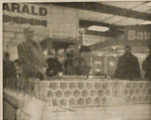
▲ Dobrym materiałem izolacyjnym na stropie jest kształtka wypalana z gliny. Fot. M. RADŁOWSKA-OBRSUNIK
