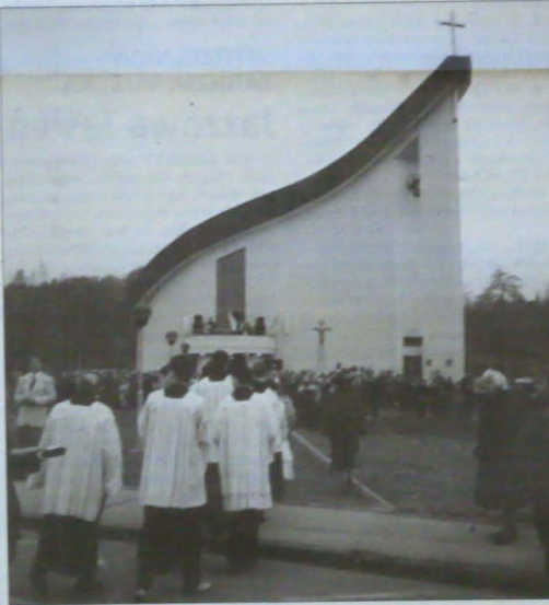
▲ Po latach starań i zabiegów mieszkańcy Łąk nad Olzą doczekali się w ub. niedzielę otwarcia nowego kościoła pw. Św. Barbary. Wnętrze nowej świątyni, zbudowanej według projektu architekta Ladislava Mirta, kosztiem 8,5 mln koron, mieści 80 miejsc siedzących i 20 stojących. Kościół poświęcił biskup diecezji opawsko-ostrowskiej, František Lobkowicz. Na zdjęciu: lejący wieniec zdający par raz pierwszy na nabożeństwo do swego nowego przybytku. Fot. ROBERT SIKORA
