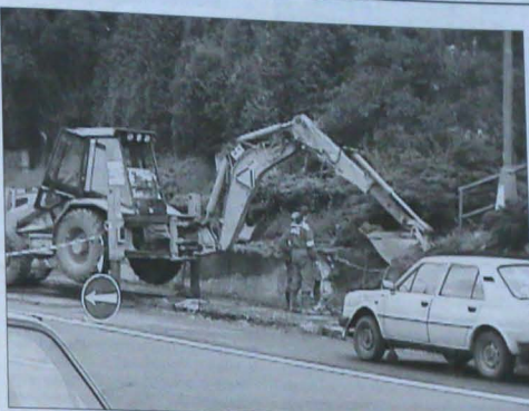
▲ Już ponad tydzień trwają prace przy rekonstrukcji mostu podciągającego zbroczę przy głównej drodze - naprzeciwko dworca kolejowego w Nawoiu. Jak poinformowała „GL” starostka wioski Lenka Husarowa, w trakcie prac prowadzonych przez ostrawską firmę Resa zostanie również odnowiony chodnik i poszerzony przystanek autobusowy. Fot. DANUTA BRANNA
