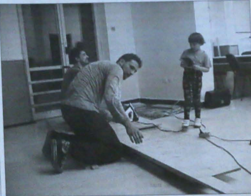
◆ Zdecydowaną większość prac przy adaptacji lokali ośrodka dziennego pobytu dla osób na rencie inwalidzkiej wykonali damowo wolontariusze, którzy pracują społecznie na rzecz Caritasu od jego powstania. Fot. D. BRANNA
