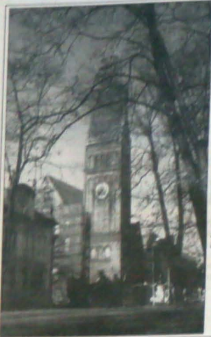
Dołbego końca drugi etap rekonstrukcji tzw. Czerwonego kościoła...
