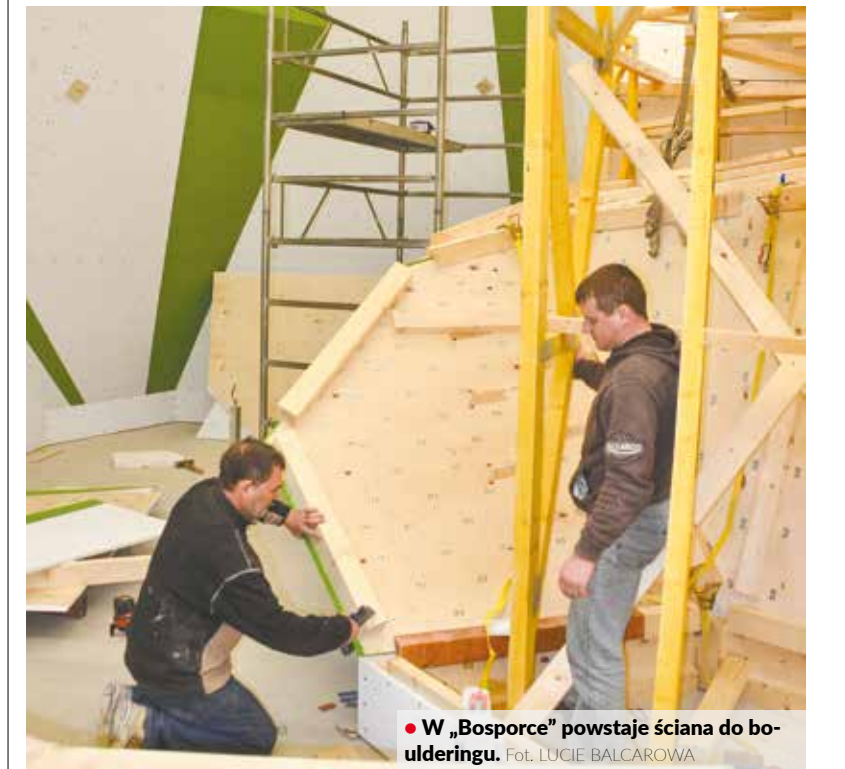
• W „Bosporce” powstaje ściana do boulderingu. Fot. LUCIE BALCAROVA
